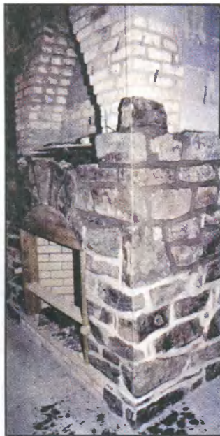
Фото 1. Нейлоновые шнуры, закрепленные на металлических штифтах на потолке и натянутые по отвесу до пола, служат направляющими при кладке углов камина.
