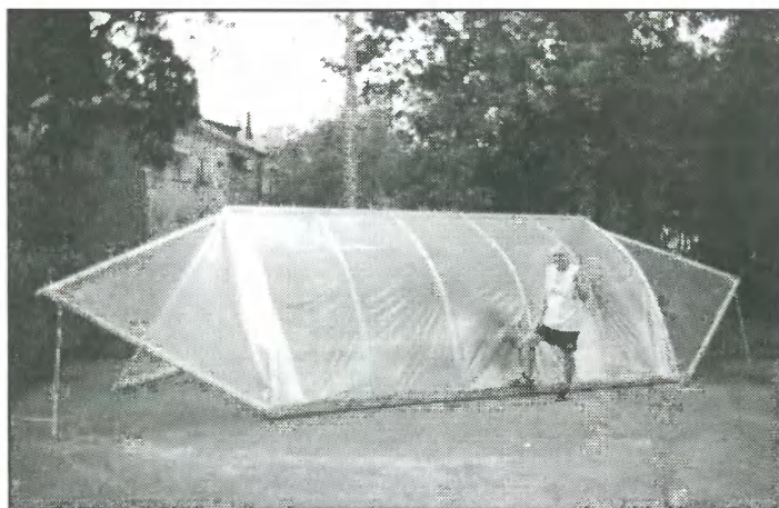
Рис. 8. Обтяжка половинок каркаса пленкой и их соединение по верхним доскам.
