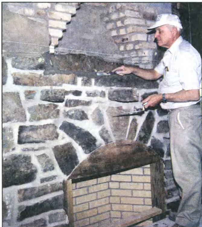
Фото 2. Арка возводится на фанерном кружале, которое вместе с рамой из досок, удерживает каменный свод до окончания всех работ по кладке и схватывания известкового раствора. После удаления кружала свод будет держаться сам. Шнур, натянутый между углами каминна, служит направляющей для выдерживания вертикальной плоскости фасада каминна при облицовке.
